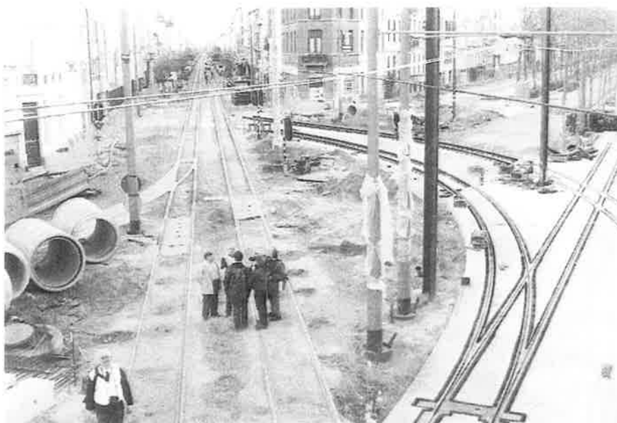
Foto onder: Een zicht vanuit een bovenleidingswagen met links de Brederodestraat en de oude sporen, en rechts de nieuwe sporen richting Bolivarplaats. Foto: Henri Janssens
